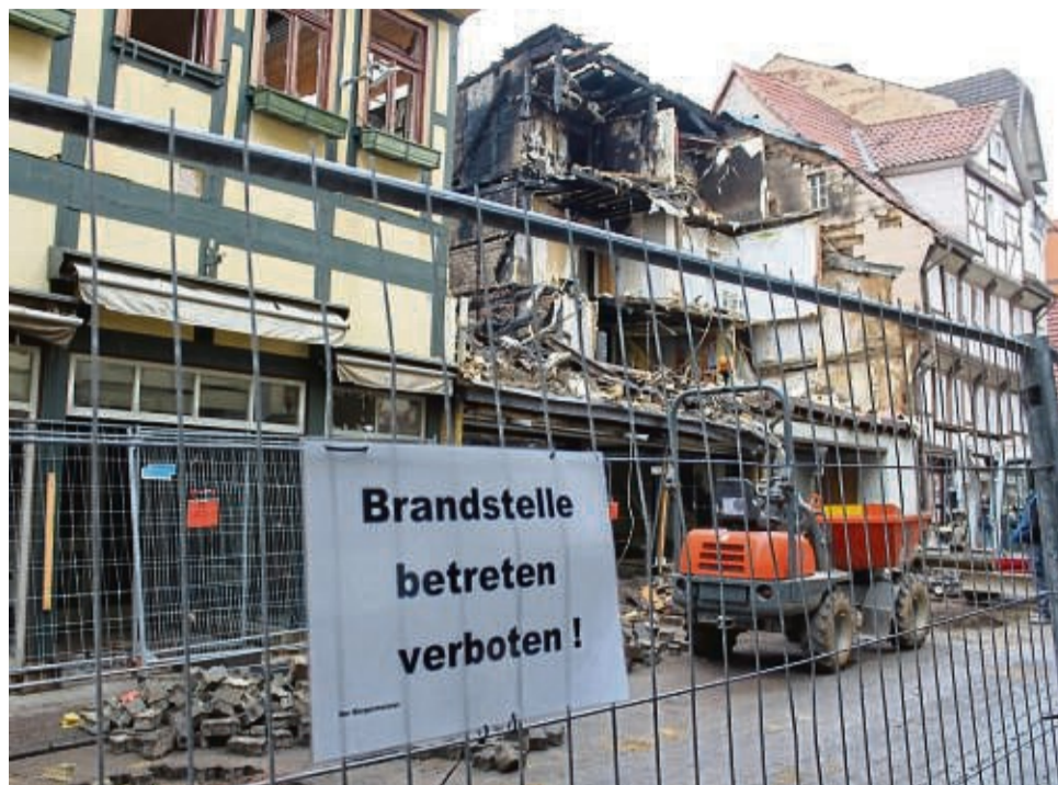
Nach dem Brand gehen die Räumarbeiten an den drei zerstörten Gebäuden in Hann. Münden weiter. Die Brandstelle war am Dienstag weiter abgesperrt. FOTO: THOMAS SCHLENZ
